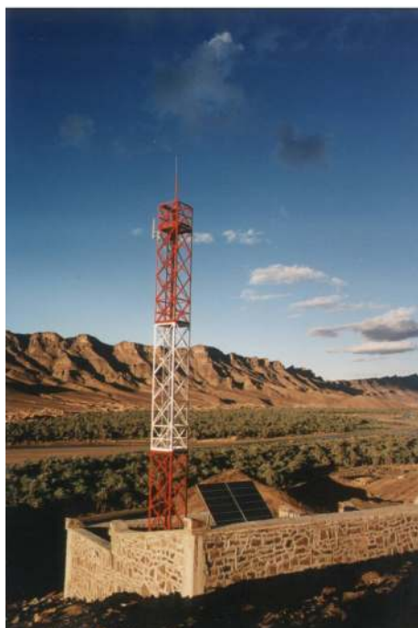
FIGURA 1.3: Sistema fotovoltaico autónomo alimentando un radioenlace.
